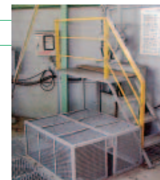
工場排水施設
