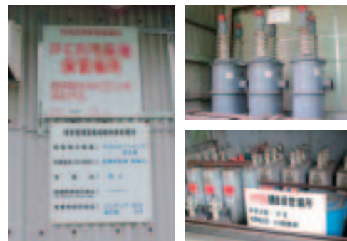
PCB廃棄物保管状況
