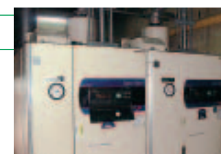
ボイラー施設
